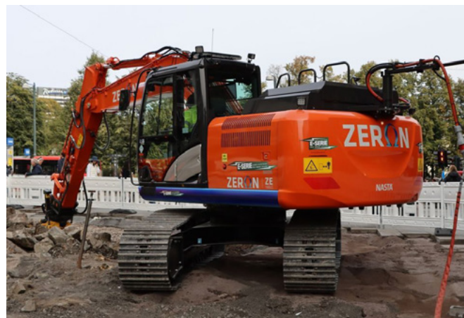
Photo: Klimaetaten, Oslo municipality
