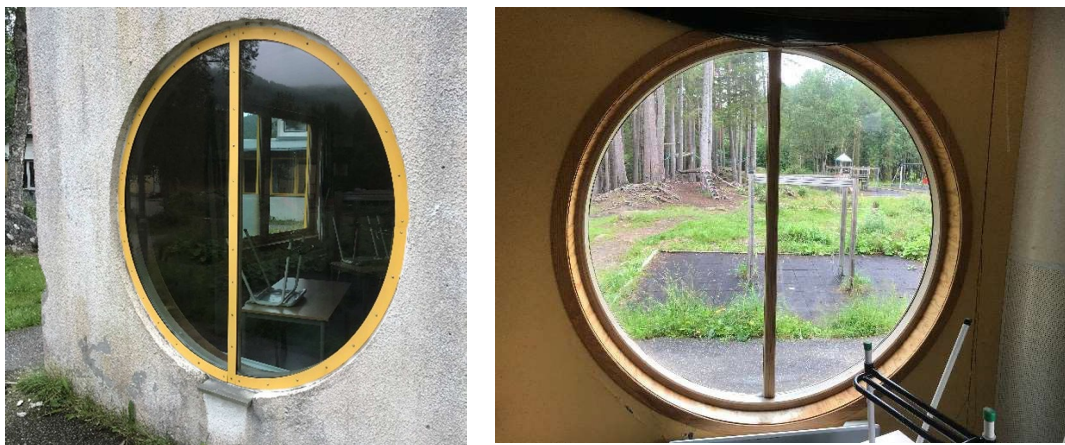
Figur 9: Runde vinduer Bygg B.
