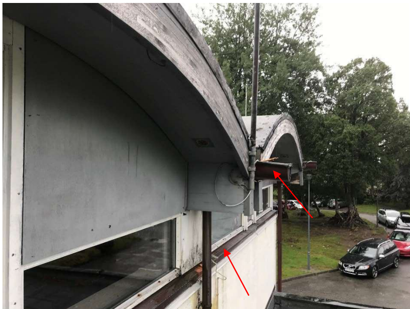
Figur 8. Kobber på fasade av Bygg C.
