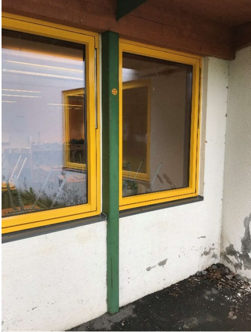
Figur 7: Stålsøyler og knekt fasade Bygg B.
