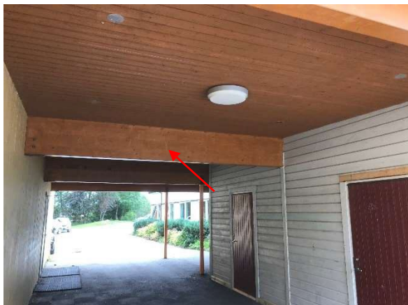
Limtre drager mellom Bygg A og C.
