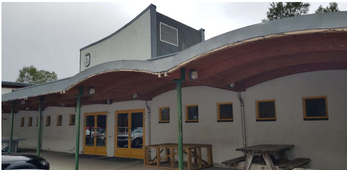
Figur 5: Buetak Bygg B.
