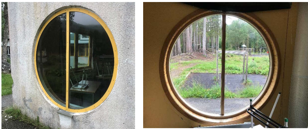
Figur 9: Runde vinduer Bygg B.
