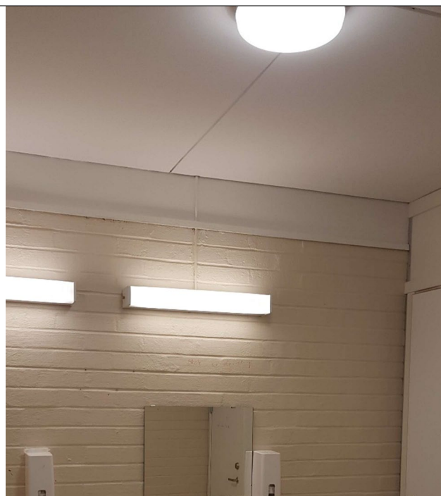
Bilde 3: Himlingsplater på WC jenter.
