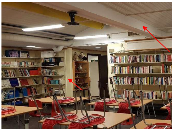
Limtresøyer og dragere i Bygg A.
