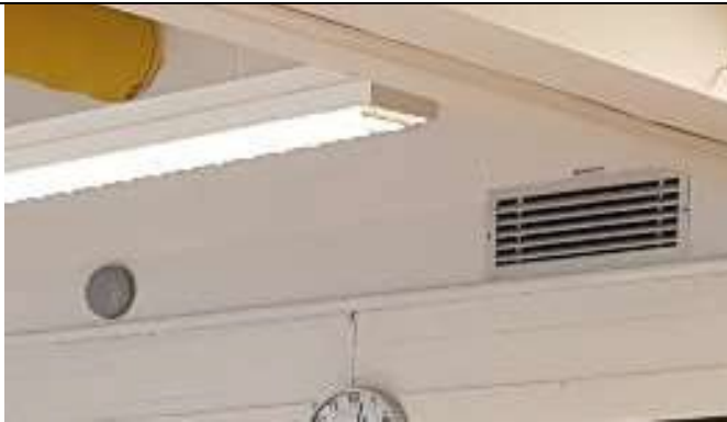
Bilde 8: Avtrekksventiler på klasserom. Det ble observert rødbrunt kitt inni flere av disse.
