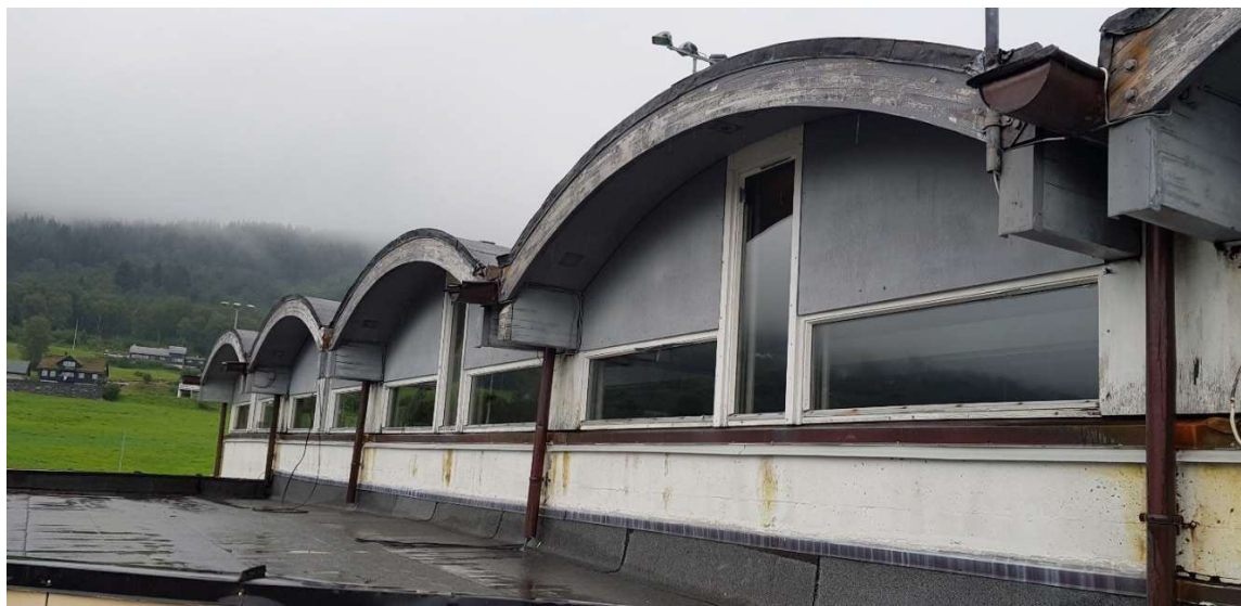
Bilde 4: Vinduer oppe på vestfasaden.
