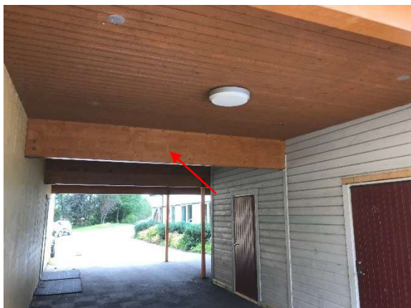
Limtre drager mellom Bygg A og C.
