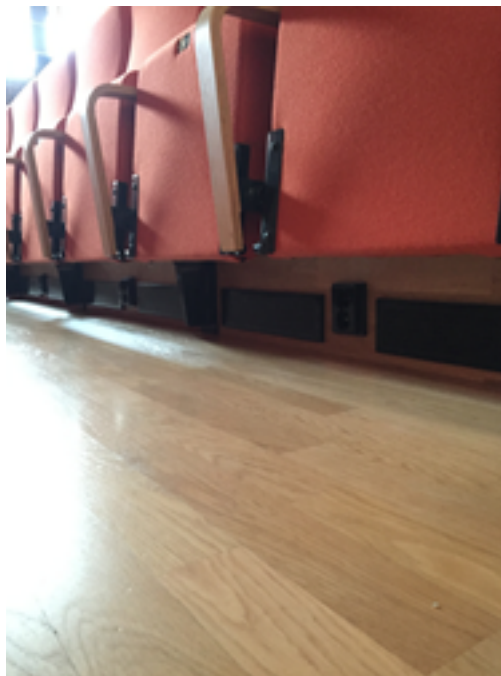
Bilde 1.19-2: Plassering av strømuttak.
