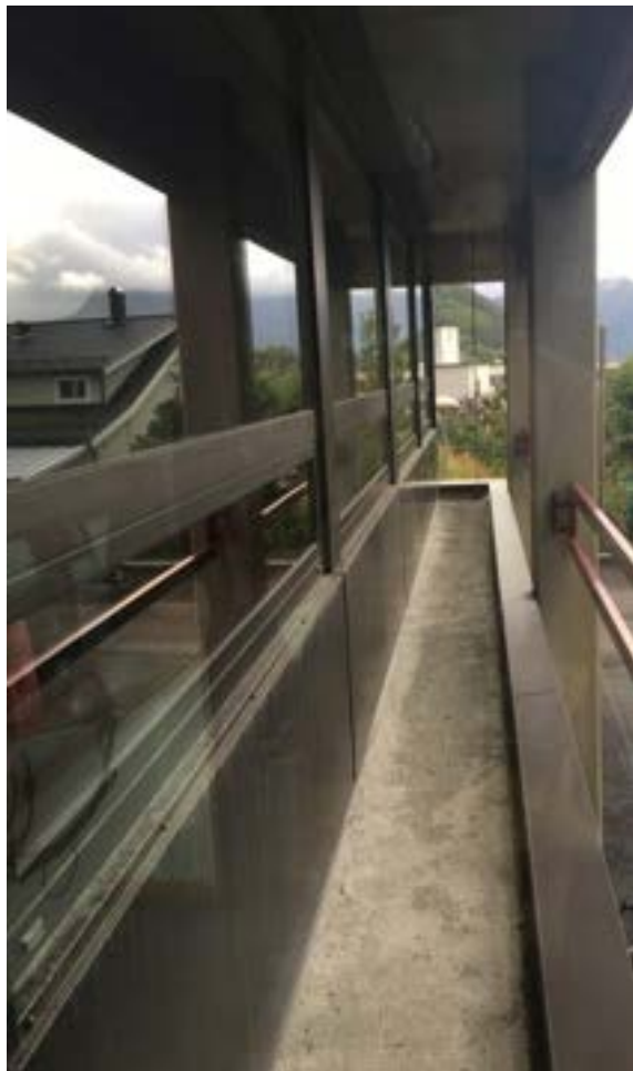
Figur 2.3.4-3. Vindusfelt mot svalegang, med tettfelt under vinduet.
