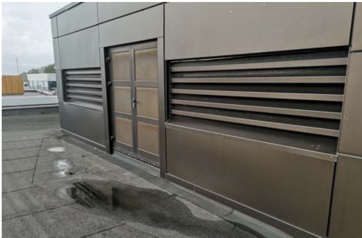
Figur 3.6.1-2: Eksisterende dør og inntaksrister på teknisk etasje plan 4
