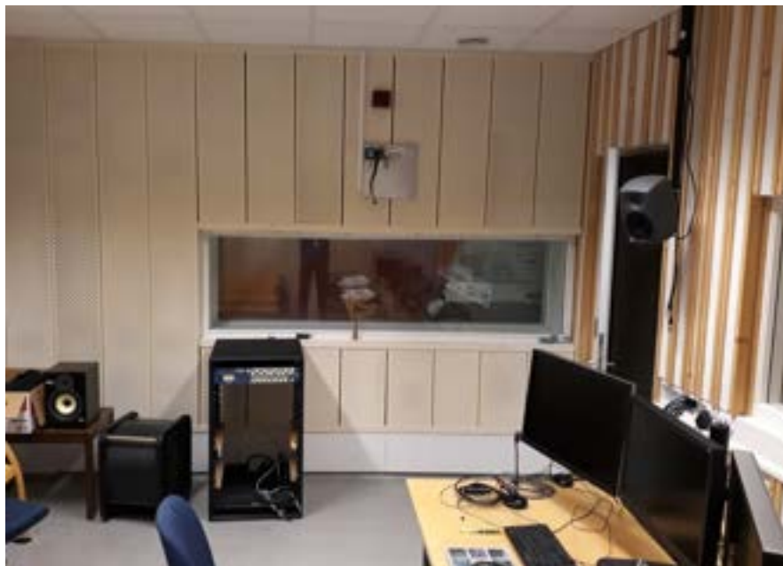
Figur 2.4.2-4. Vindu mellom rom HS-082 og HS-087.
