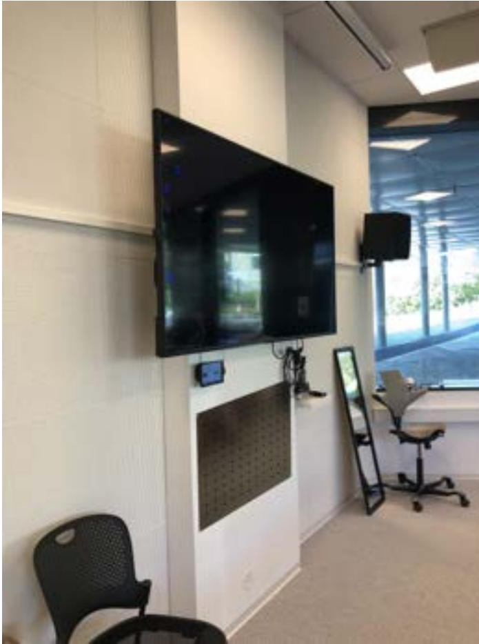
Figur 4.3.3-6 Eksempel på kasse med deksel under skjerm.
