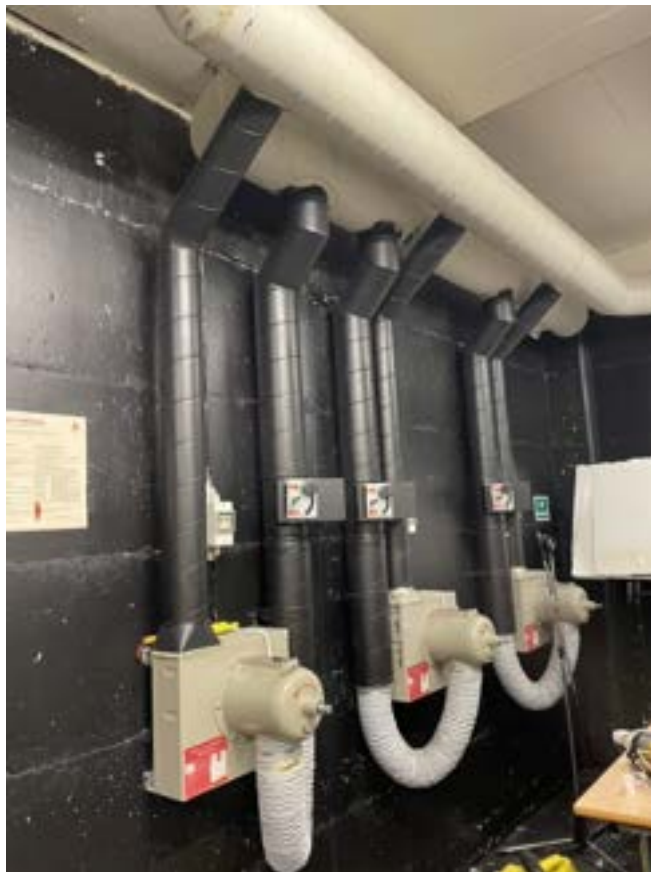
Figur 3.0.1-1 NORFO ventilasjonsystem
