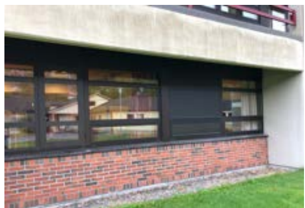
Figur 2.3.4-2. Fasade nord. Foliering/ tettfelt mellom vinduer.
