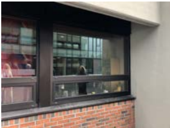
Figur 2.3.4-1 Vindu på vestfasaden.
