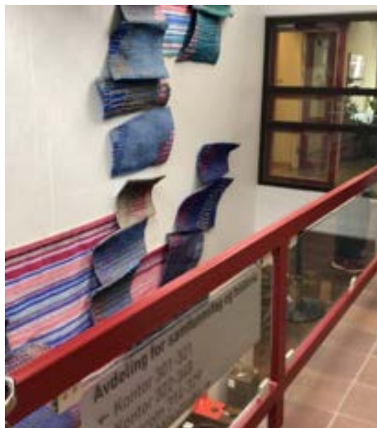
Figur 2.8.7-3. Rekkverk ved åpent opp - areal
