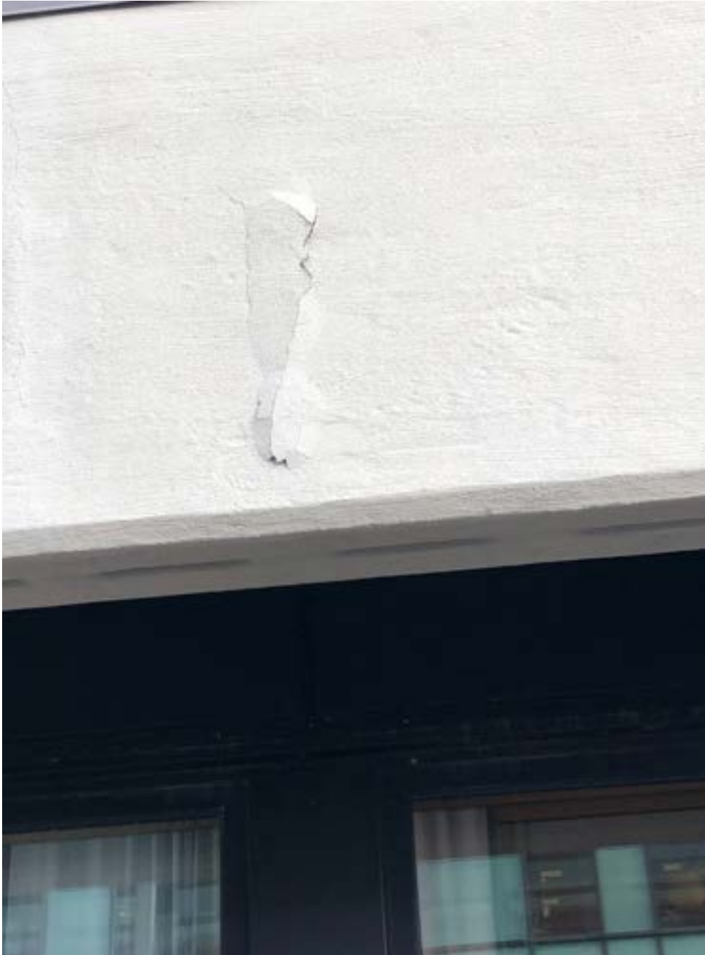
Figur 2.2.9. Skadet armering på utvendig betongdrager.
