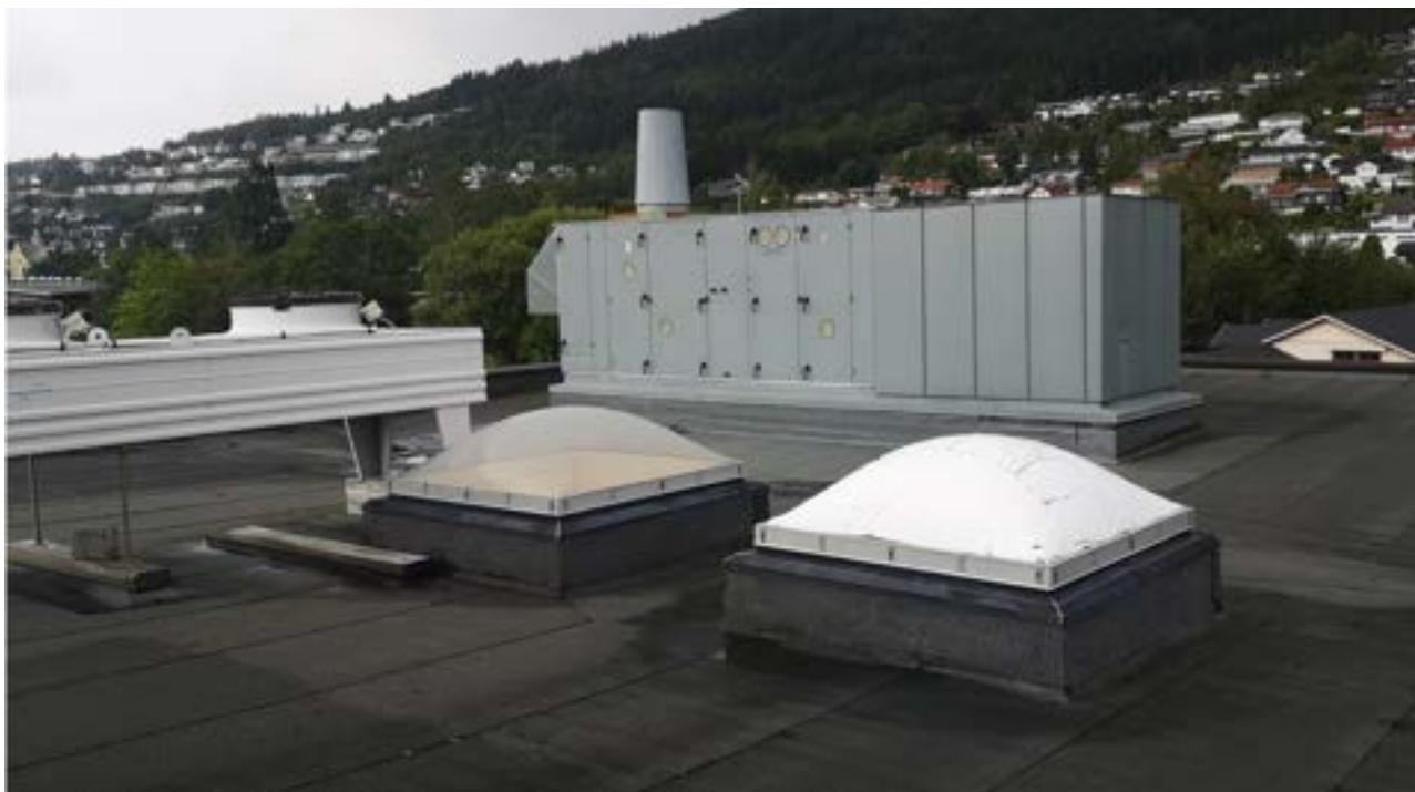
Figur 3.6.1-1: Eksisterende aggregat på tak
