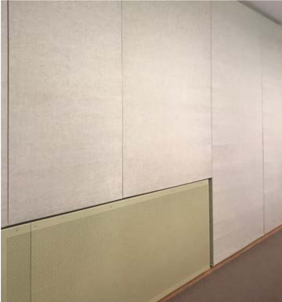
Figur 2.5.6. Gjenbruk av mineralullhimling som veggabsorbent, Powerhouse Kjørbo.
