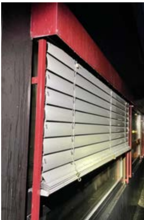
Figur 2.3.7-2. Utvendig persienne på plan 3.
