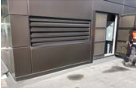
Figur 1.19.2-1. Teknisk rom på tak.
