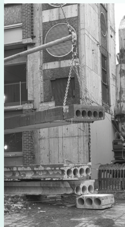
Fra demontering av hulldekker i R4 i Regjeringskvartalet i Oslo. Statsbygg og Veidekke. Foto: Veidekke
