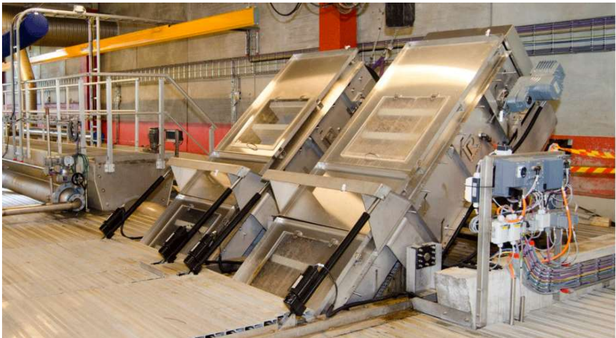
Figur 9: Transportbelte som sørger for flytting av bæremedium mellom siste og første sone i prosessen. (Kilde: Hias.no, 29.06.21, https://www.hias.no/hias-how2o/om-hias-how2o/ )
